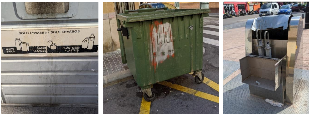
FIGURA 28. Contenedor en malas condiciones con necesidad de sustitución y limpieza de la zona en diversos puntos del municipio de Burriana
