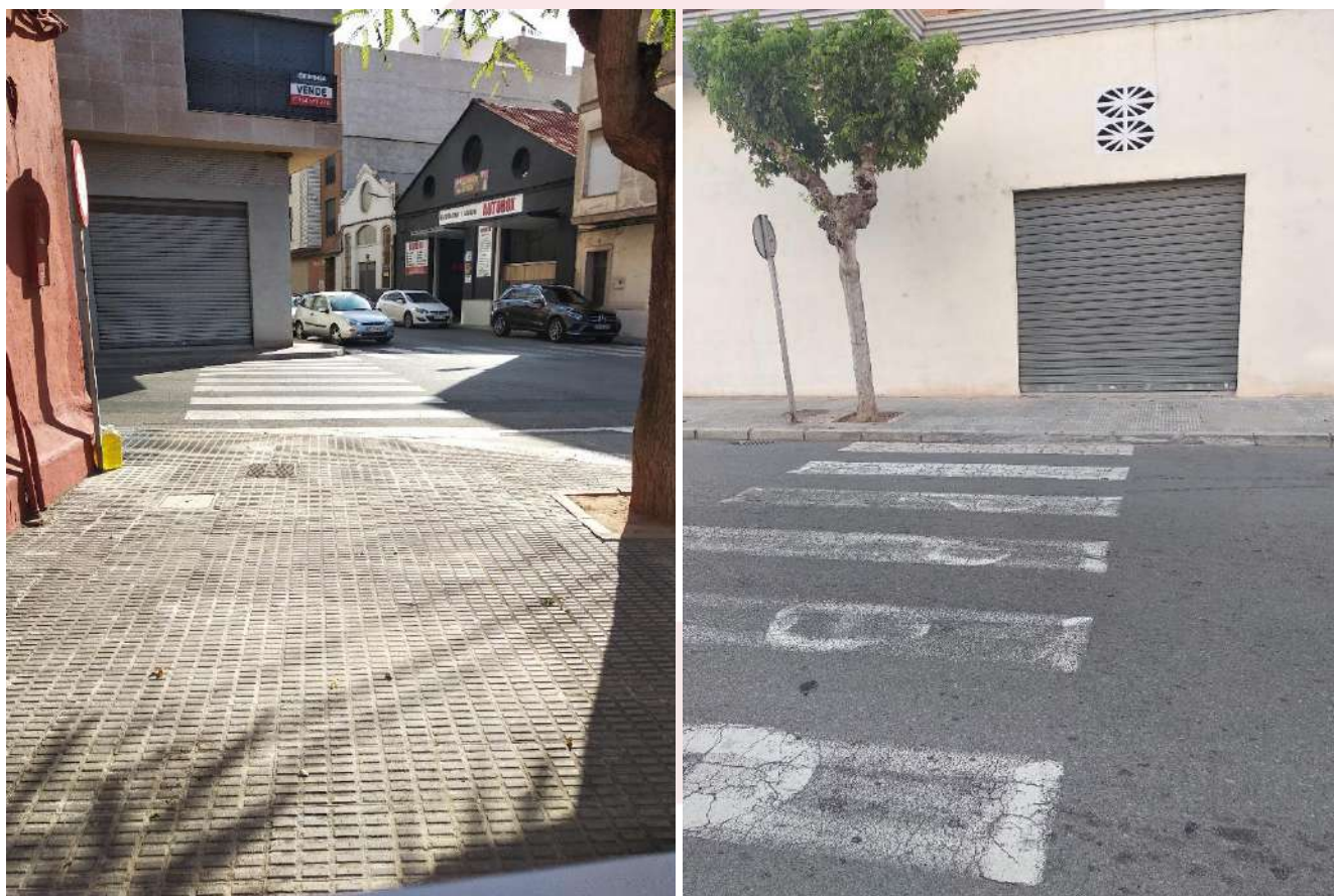
Imagen 6-14 Pasos peatonales sin rebaje. Foto izquierda: calle Benito Pérez Galdós. Foto derecha: calle La Vieta. Elaboración propia.
