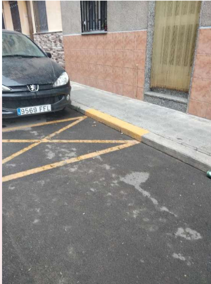
Imagen 6-16 Plaza PMR sin rampa. Calle San Fermín. Elaboración propia.
