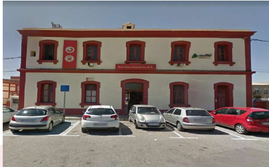
Imagen 6-27 Estación de tren Borriana-Alquerías del Niño Perdido. Fuente: Google Maps.
