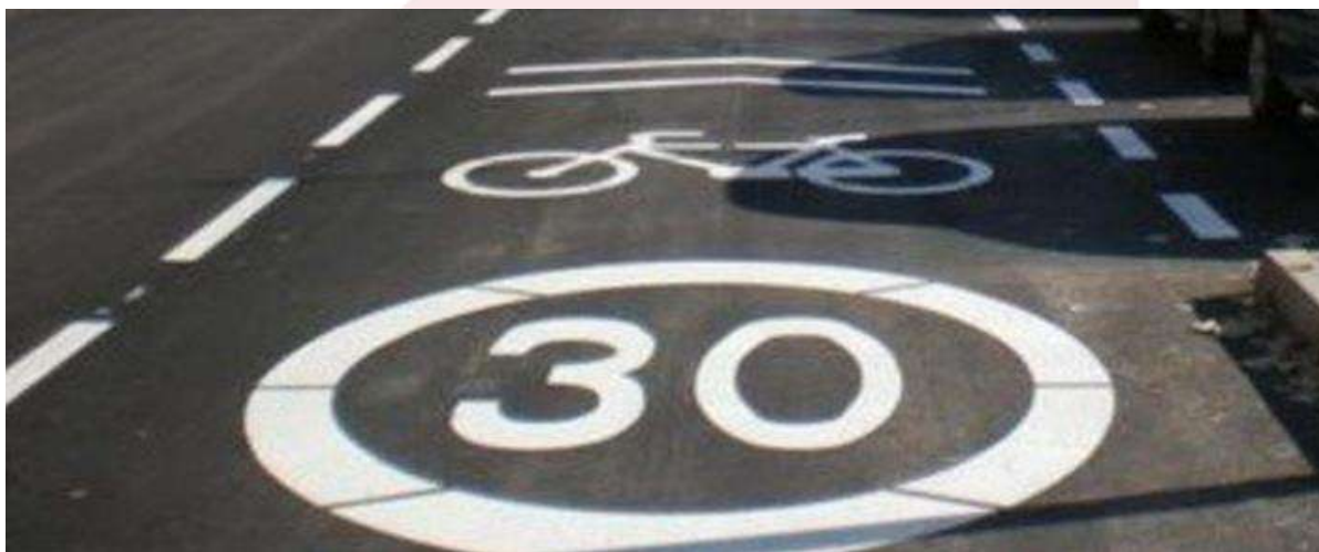
Imagen 10-13 Ejemplo de señalización horizontal de una ciclo-calle.
