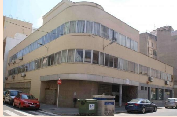
Estado actual del edificio
