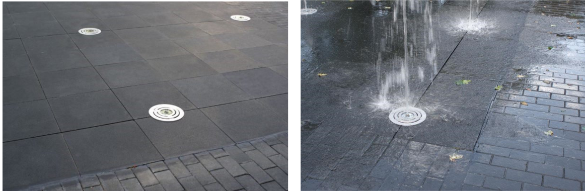
Imágenes de fuente integrada en el pavimento que desaparece por completo cuando no se encuentra en uso
