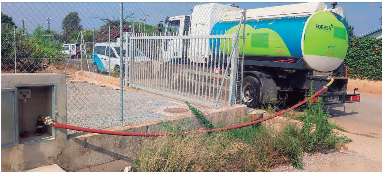
En el Pozo Burriana 6 se dispone de un depósito con una capacidad aproximada de 70 m<sup>3</sup>, diseñado para almacenar las aguas procedentes del lavado de los filtros de carbón activo. Hasta ahora, estas aguas se retiraban y se trasladaban a la Estación Depuradora de Aguas Residuales (EDAR). Con la puesta en marcha de este nuevo punto de carga, dichas aguas serán reutilizadas para la limpieza y el baldeo de las calles y plazas de Burriana.
