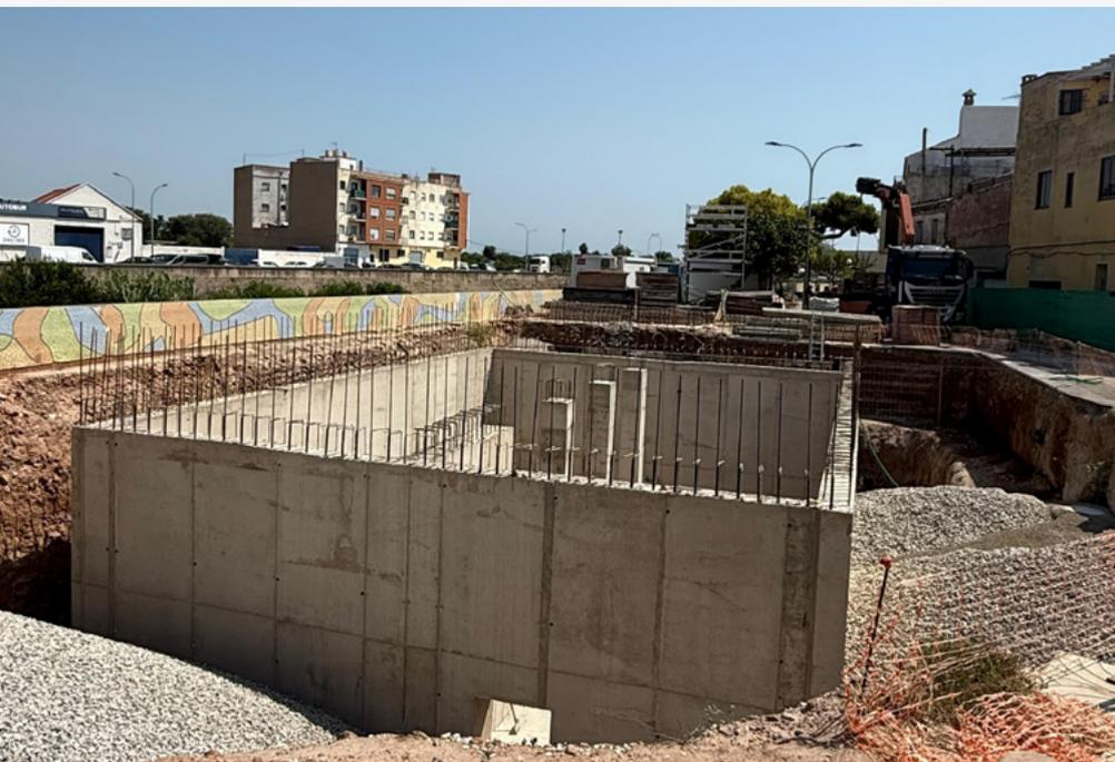
Burriana continuó con la construcción de su nueva red separativa de aguas pluviales con el tramo final para la ejecución del nuevo tanque de tormentas de la plaza Sant Blai, después de que el pasado mes de marzo tuvieran que paralizar temporalmente las obras tras detectarse por parte del personal técnico la presencia de antiguos edificios en la zona de excavación.
