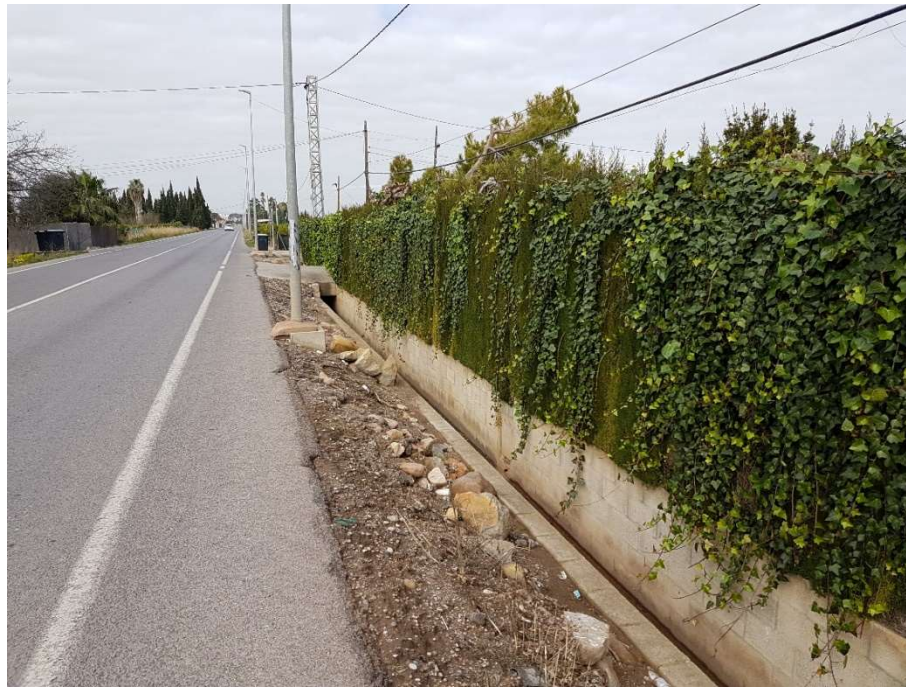
Fotografía 16.- PK 0+940 Paseo peatonal
