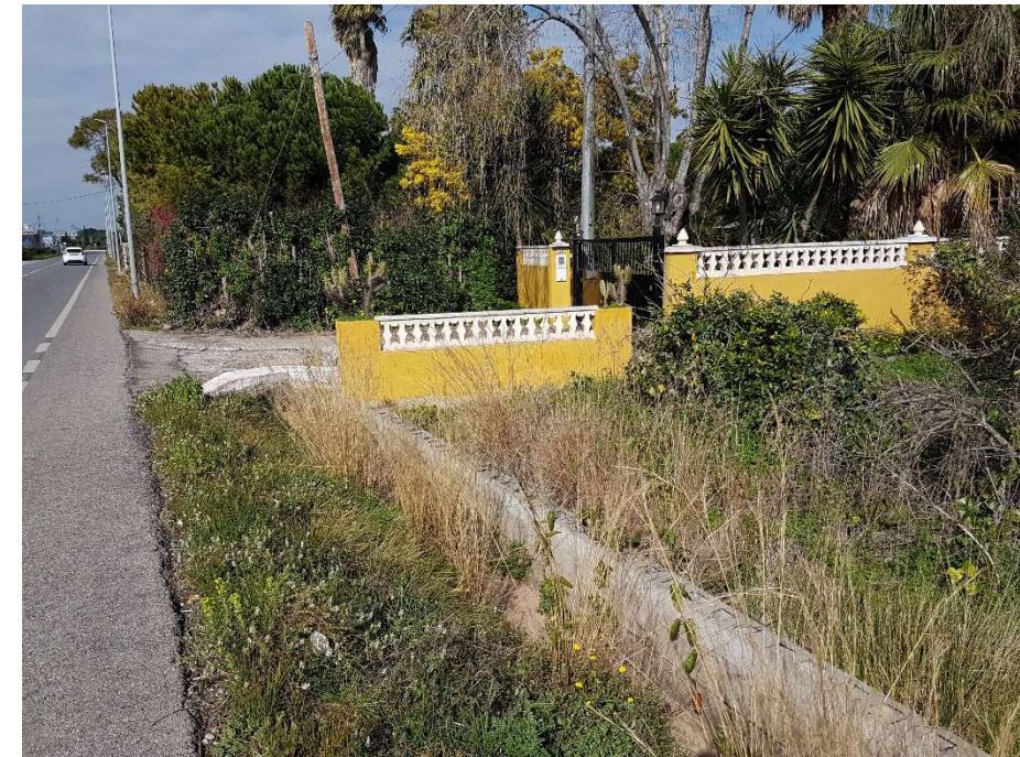
Fotografía 6.- PK 0+260 Zona de ampliación.
