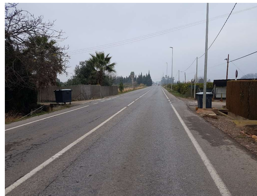
Fotografía 15.- PK 0+905 Cruce carril bici. Camí de la Ermita de la Misericòrdia
