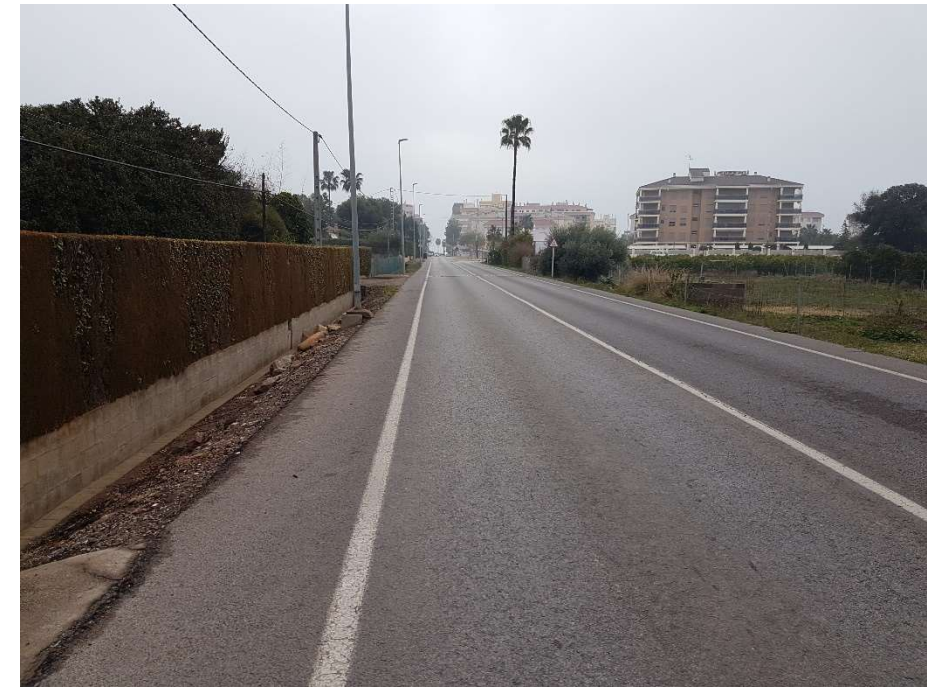
Fotografía 18.- PK 0+960 Paseo peatonal.
