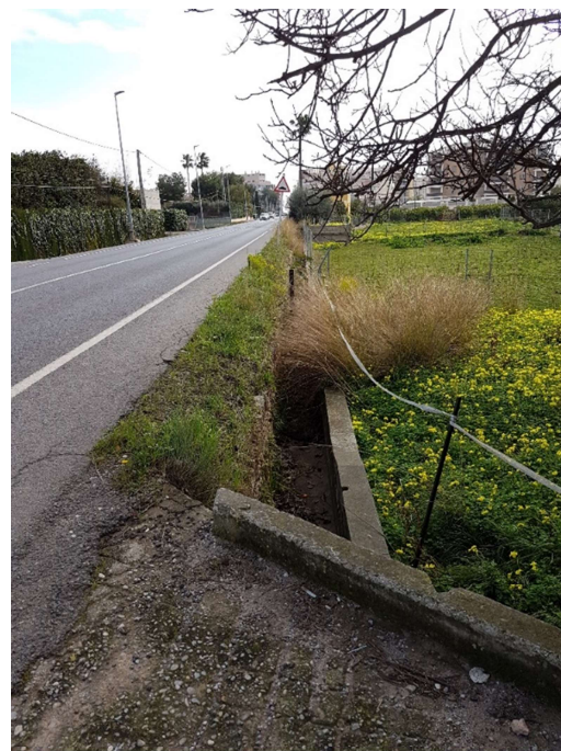
Fotografía 17.- PK 0+000 (eje derecho) Carril bici
