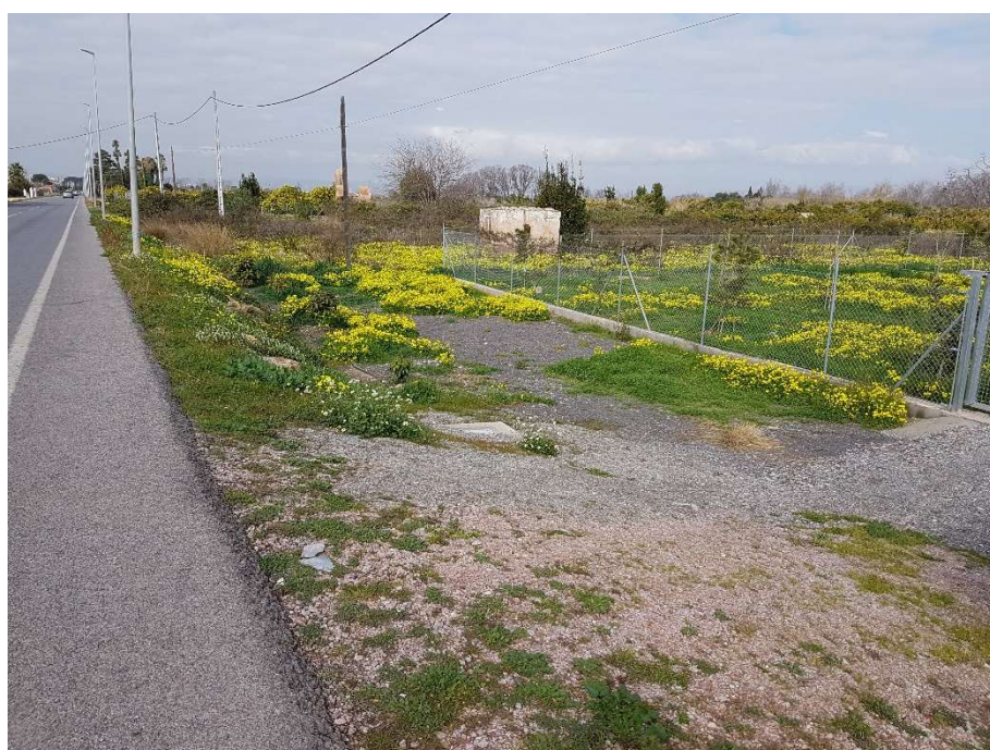
Fotografía 13.- PK 0+810 Zona de ampliación.
