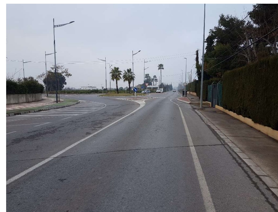
Fotografía 23.- PK 1+130 Paseo peatonal
