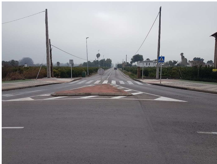
Fotografía 1.- Inicio de la obra, realización del cruce del carril bici.
