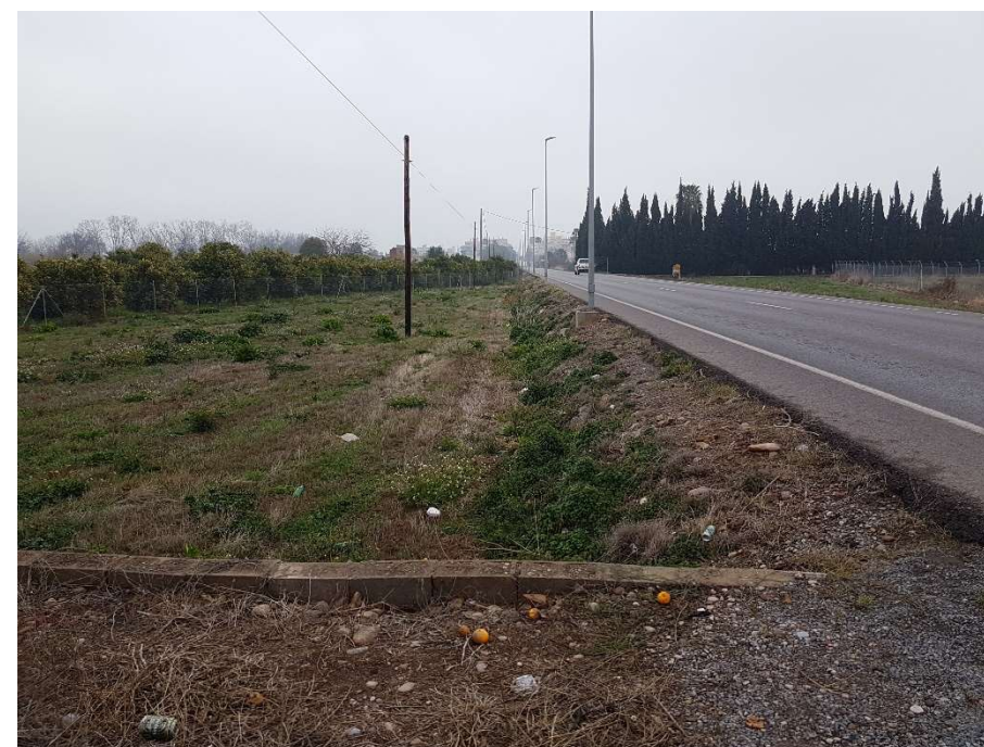
Fotografía 10.- PK 0+595 Zona de ampliación (vista hacia el PK 1+256,35)
