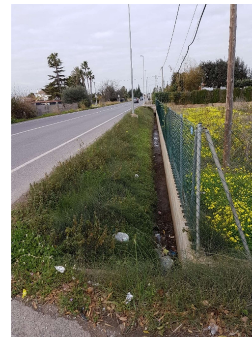
Fotografía 19.- PK 1+015 Paseo peatonal
