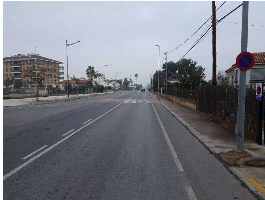
Fotografía 24.- PK 1+205 Paseo peatonal
