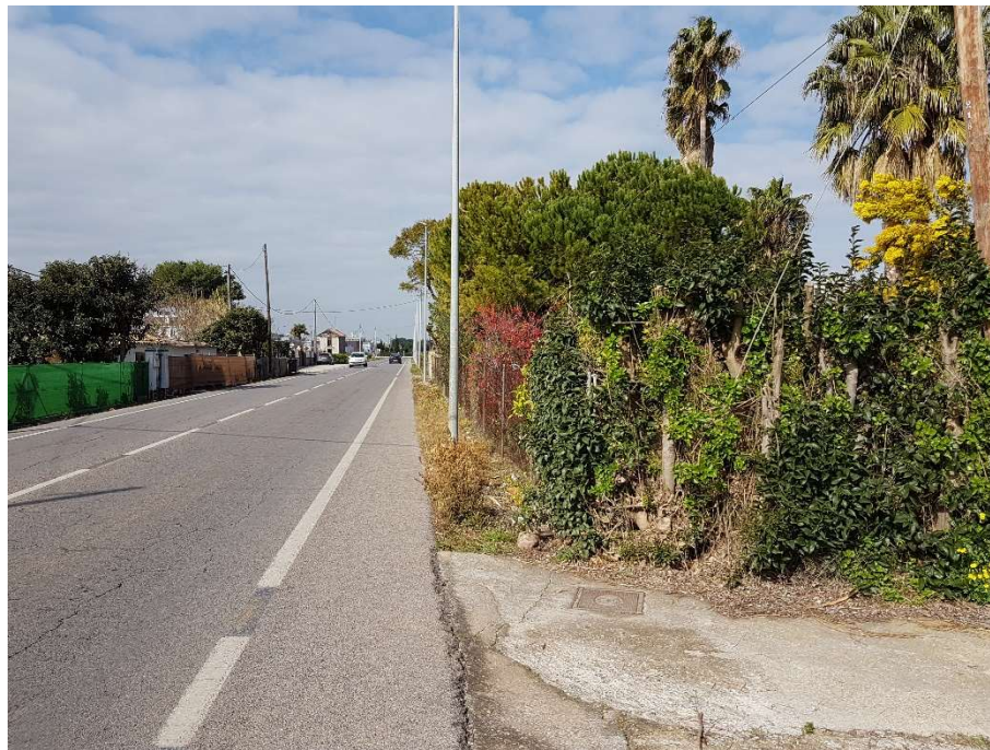
Fotografía 5.- PK 0+240 Arbolado a talar.
