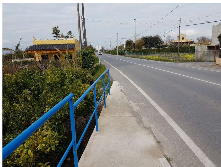
Fotografía 21.- PK 0+135 (eje derecho) Carril bici
