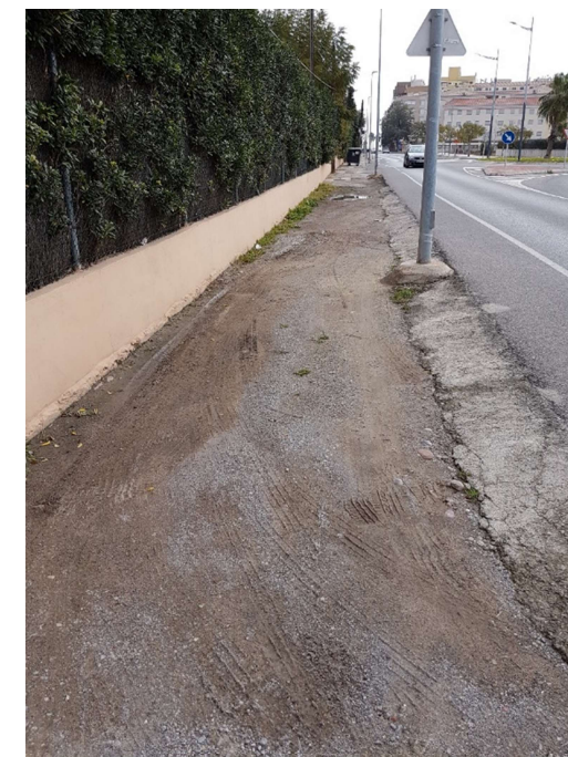
Fotografía 22.- PK 1+020 Paseo peatonal.
