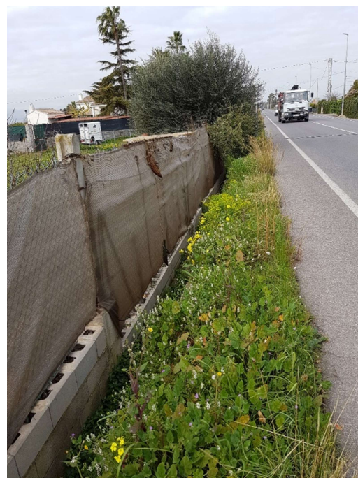
Fotografía 20.- PK 0+080 (eje derecho) Carril bici
