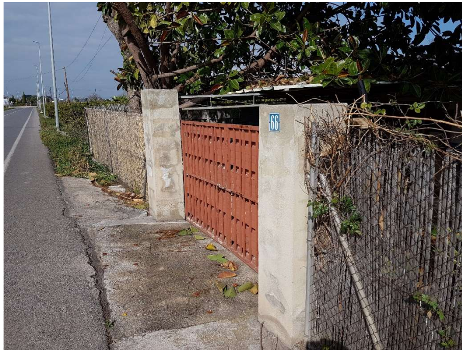
Fotografía 4.- PK 0+200, puerta corredera a desmontar y reponer.
