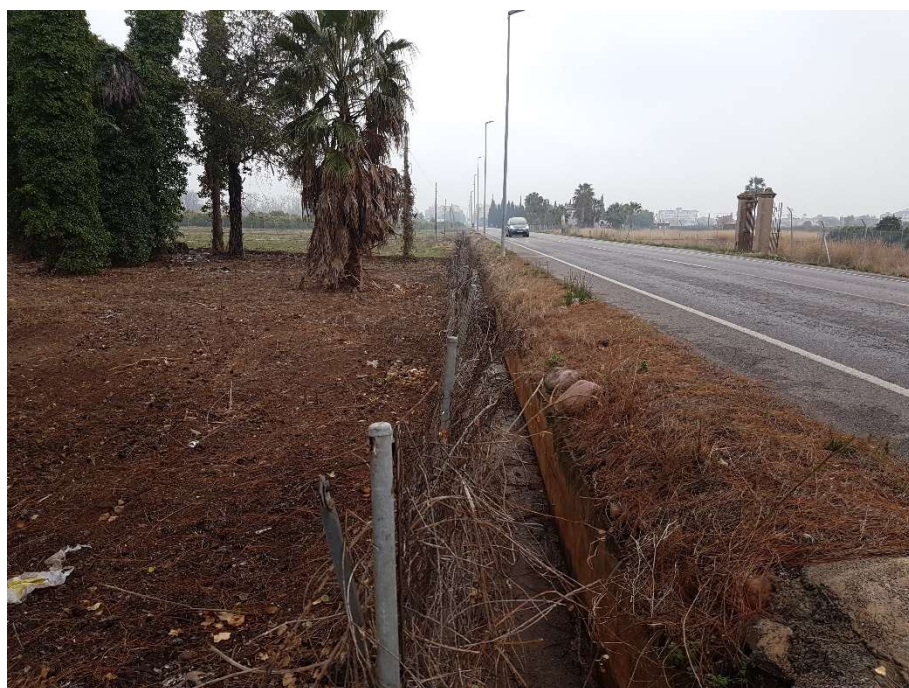
Fotografía 8.- PK 0+395 Zona de ampliación (vista hacia el PK 1+256,35)
