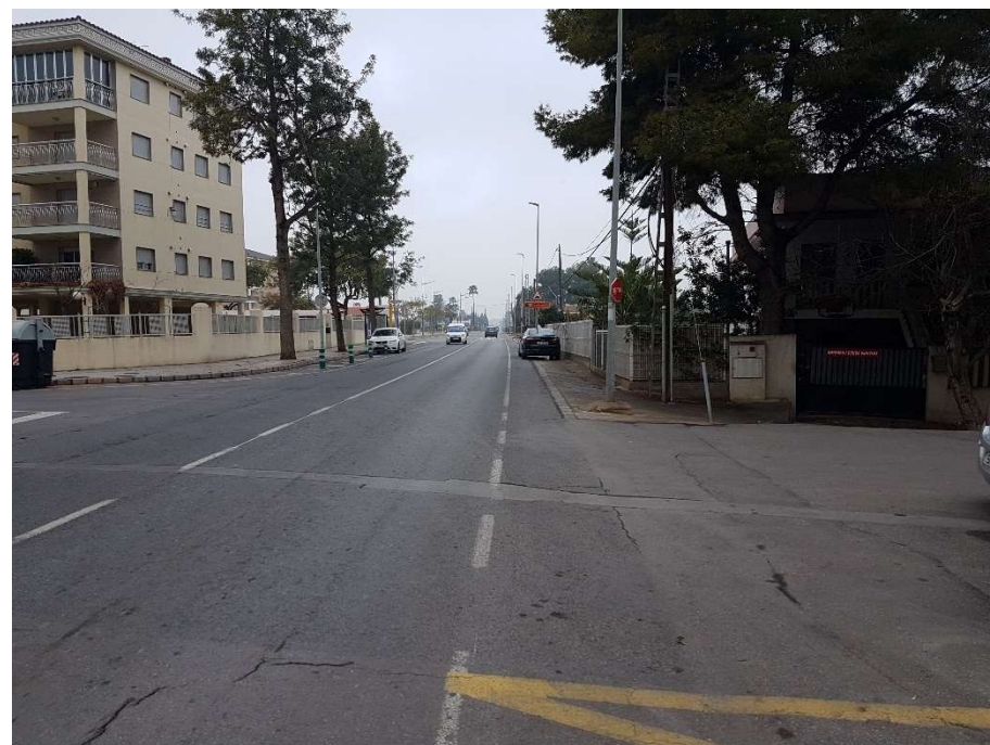
Fotografía 25.- PK 1+256,35 Finalización del paseo peatonal.
