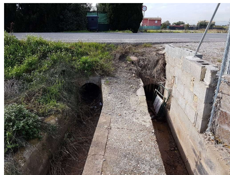
Fotografía 11.- PK 0+718 Acequias a entubar.
