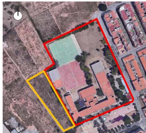
Imagen aérea de la actual situación. En rojo, parcela actual del IES Jaume; en amarillo nueva parcela aportada por el Ayuntamiento
