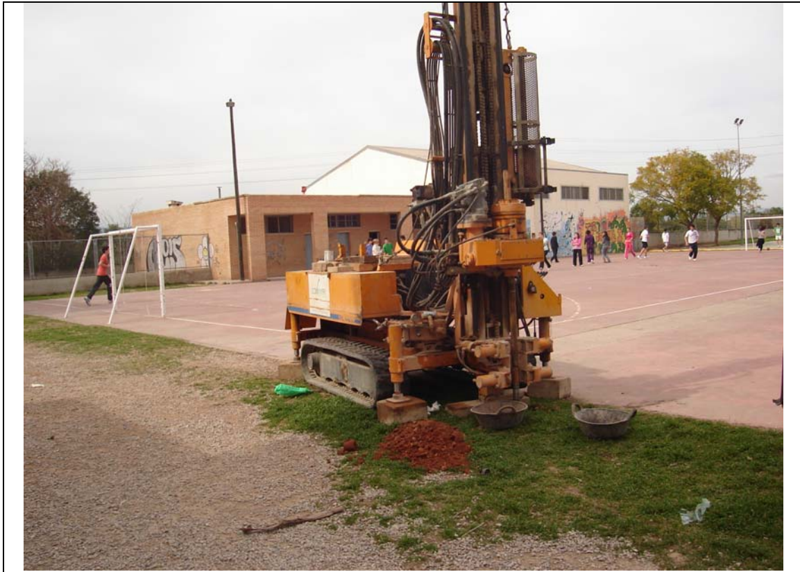
Emplazamiento del sondeo de reconocimiento SM-03
