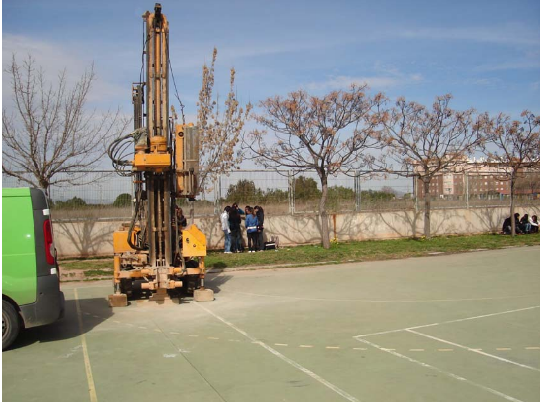
Emplazamiento del sondeo de reconocimiento SM-02
