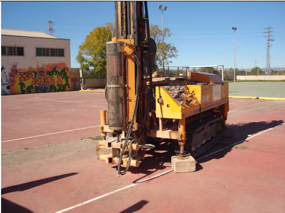
Emplazamiento durante la realización del la PD-2
