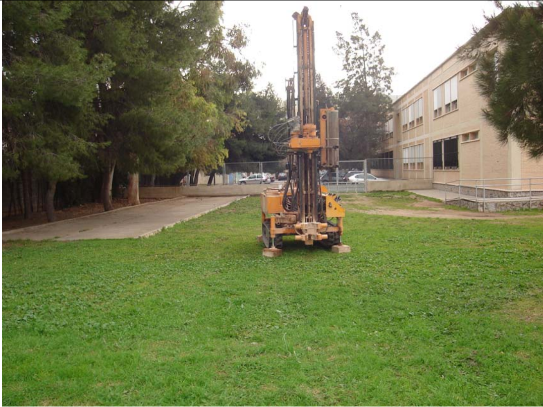
Emplazamiento del sondeo de reconocimiento SM-01
