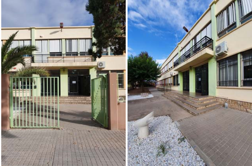
Fachada principal. Plaza Manuel Sanchís Guarner
