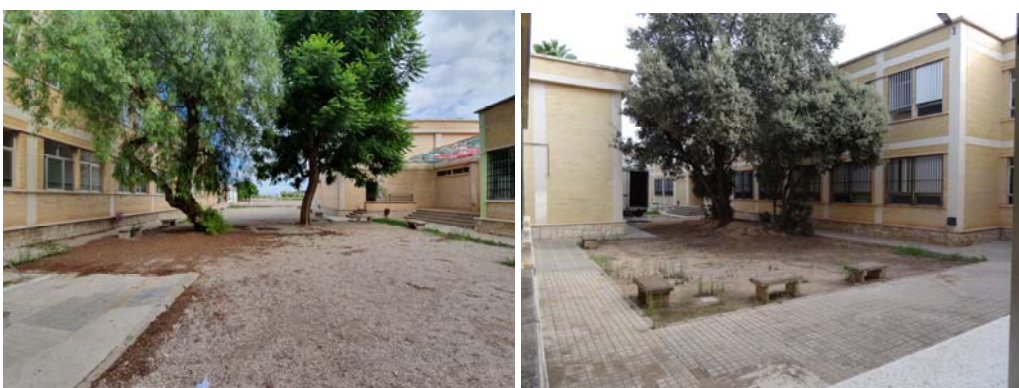
Patios exteriores entre volúmenes edificados
