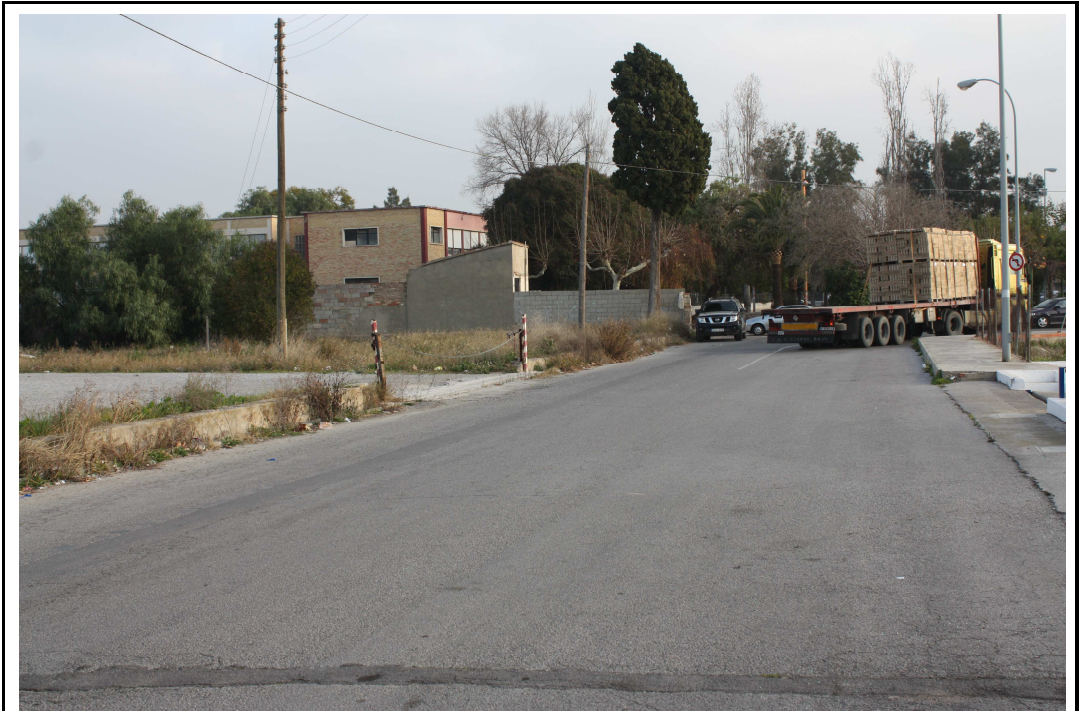
FOTO Nº5 Vista desde Camí Vell de Valencia hacia la que será la Avenida del Transporte
