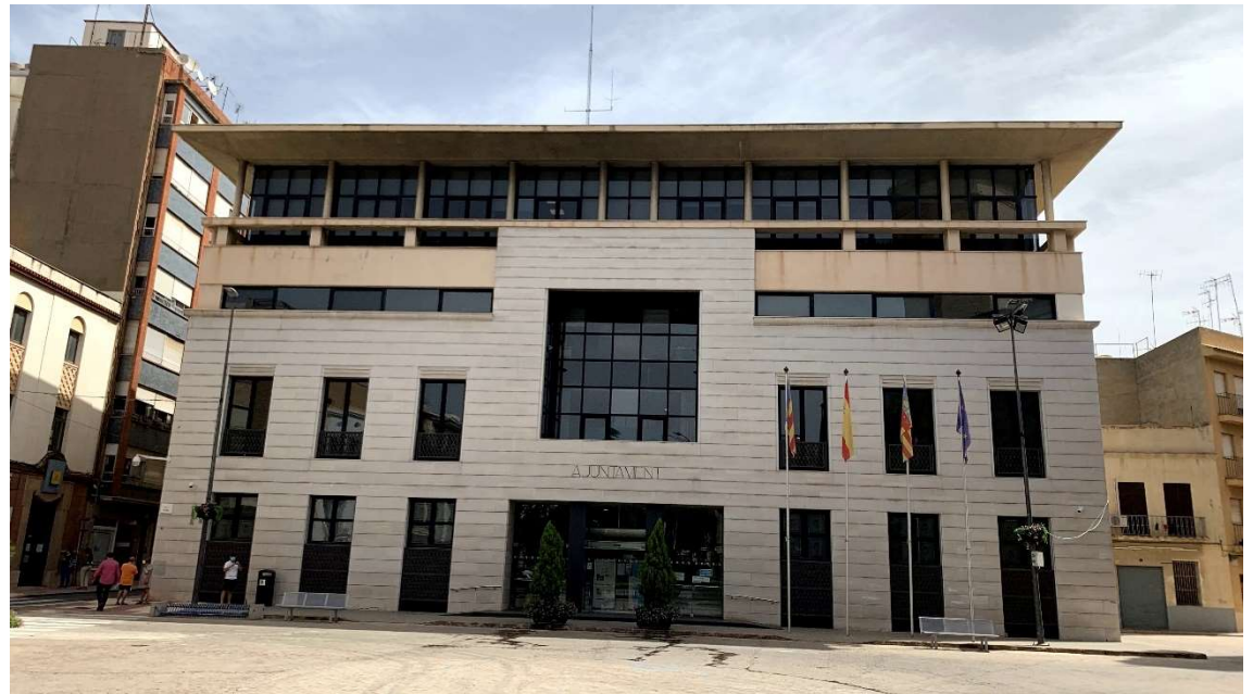
Ilustración 3. Detalle de la fachada del edificio consistorial.
